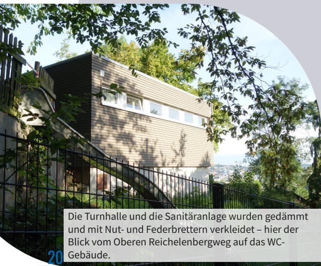
Die Turnhalle und die Sanitäranlage wurden gedämmt und mit Nut- und Federbrettern verkleidet – hier der Blick vom Oberen Reichelenbergweg auf das WC-Gebäude.
